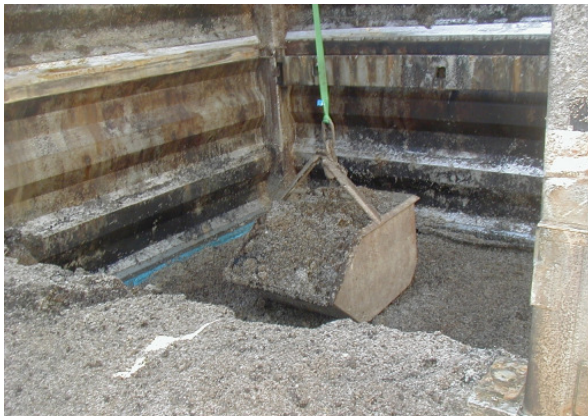
Austausch des Biofiltermaterials auf der ARA Rhein, Pratteln
