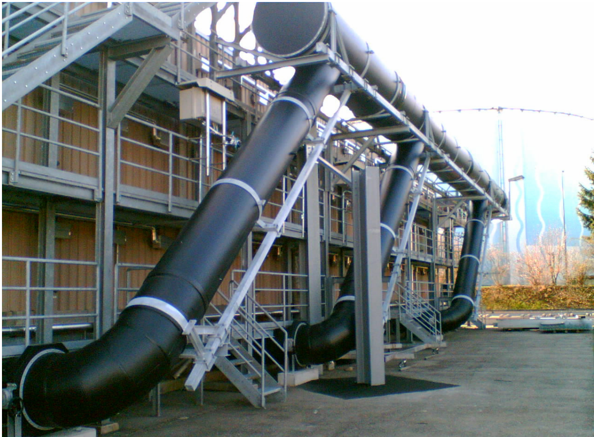
Im Biofilter der ARA Rhein in Pratteln werden bis zu 60'000 m 3 /h schwach belastete Abluft behandelt
