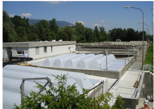
Abdeckung zweier Schlammbecken zum gezielten Absaugen von geruchsbelasteter Abluft mit entsprechender Behandlung bei der Borregaard Schweiz AG, Riedholz
