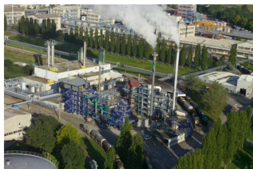
Zwei Verbrennungsanlagen, deren Rauchgasreinigungsstufe mit Ring-Jet's ausgerüstet wurden, um tiefe Staubemissionswerte zu erreichen
