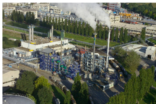
Zwei Verbrennungsanlagen, deren Rauchgasreinigungsstufe mit Ring-Jet's ausgerüstet wurden, um tiefe Staubemissionswerte zu erreichen
